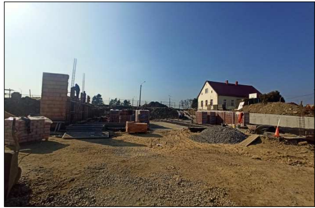
OSP ŁĄZY W BUDOWIE (7)
